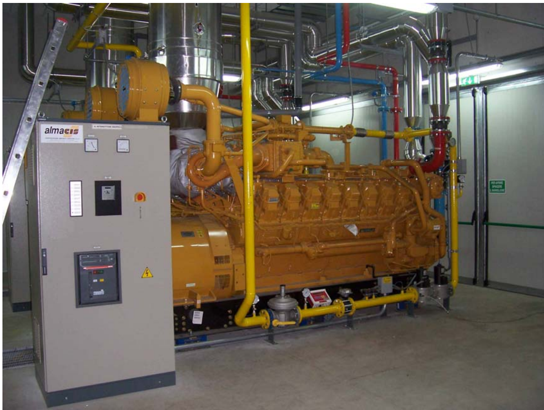
Figura 10. Motore a combustione interna in una centrale di cogenerazione.
