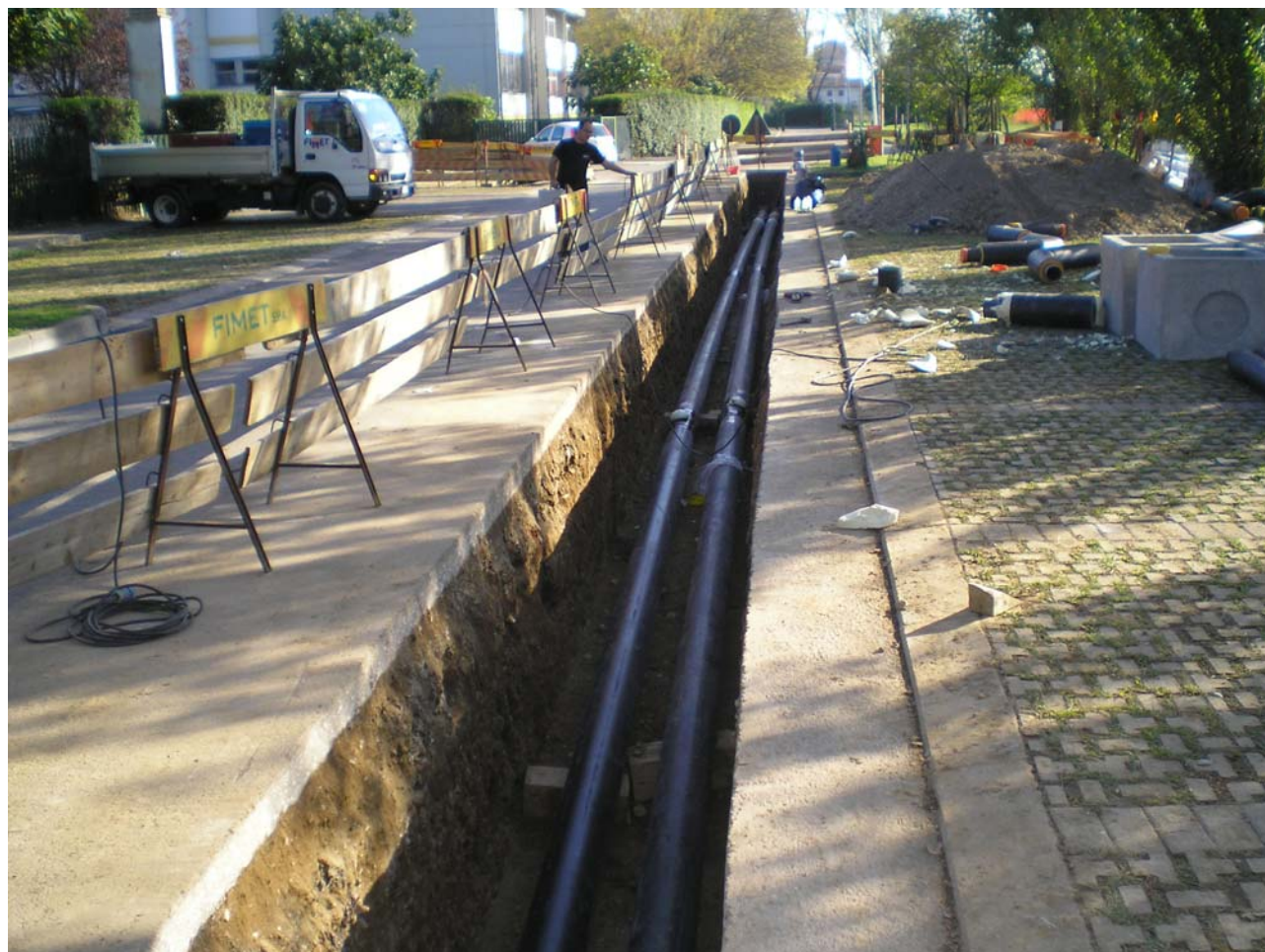
Figura 9. Posa delle tubazioni della Rete di Teleriscaldamento a servizio di una centrale di cogenerazione.
