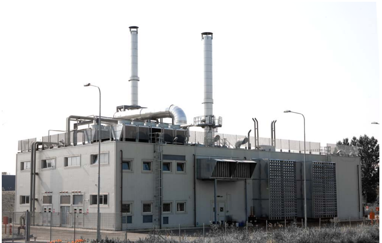
Figura 8-Impianto di cogenerazione abbinato al teleriscaldamento
